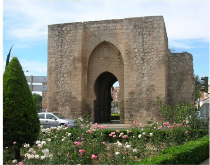
La humedad llega hasta los 2 metros de altura
